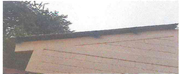
Sustitución de cubierta de lamina en todo el establecimiento educativo
