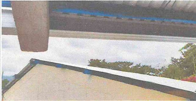
Sustitución de cubierta de lamina en todo el establecimiento educativo
